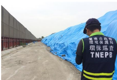
車行路徑鋪設PC面 物料堆置覆蓋防塵網
