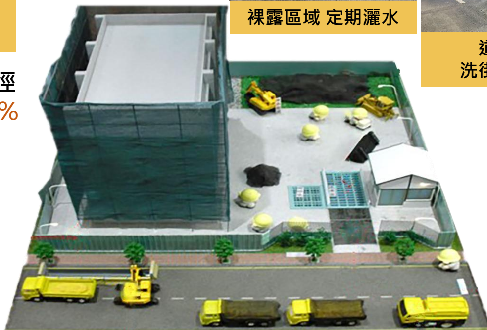
全阻隔式施工圍籬 (隔音、防塵)
