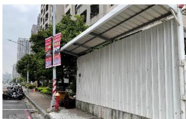
全阻隔式施工圍籬 (隔音、防塵)
